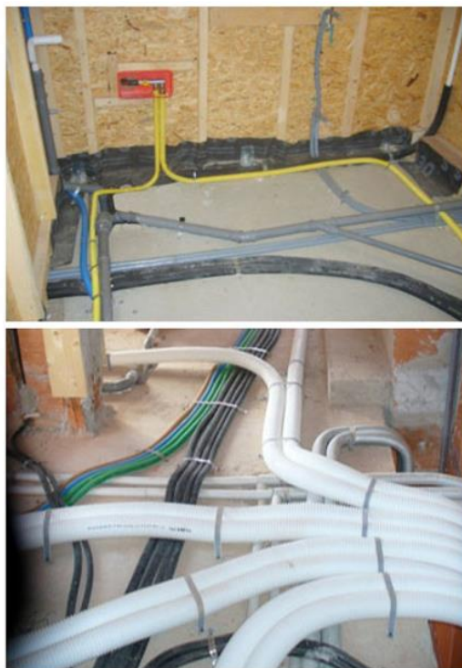
Disposizione impianti con cordolo tradizionale o senza cordolo
