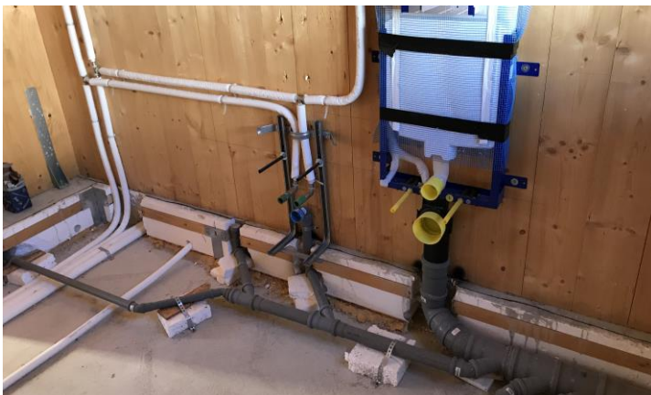
Risalite impianti in parete
